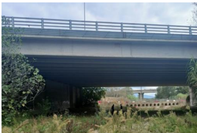
Εικόνα 2: Όψη του τοιχείου κάτω από τον αυτοκινητοδρόμο Αθηνών-Θεσσαλονίκης όπου θα αγκυρωθεί τμήμα του αγωγού
