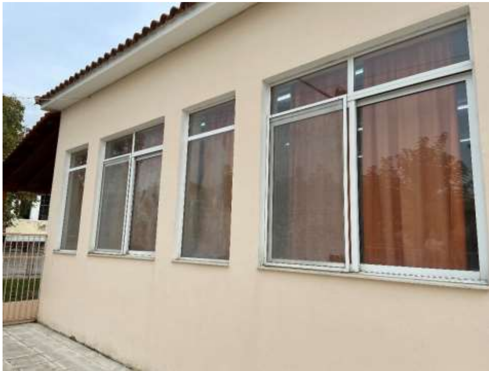
Εικόνα : Εξωτερική όψη κουφωμάτων κτιρίου
