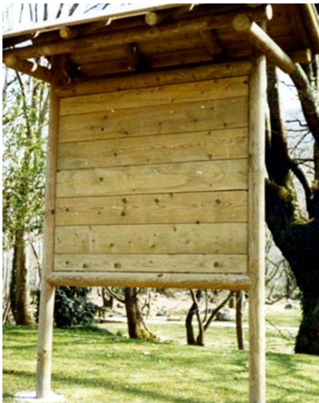
Εικόνα 1: Ξυλοκατασκευή Πινακίδας Υποδοχής
